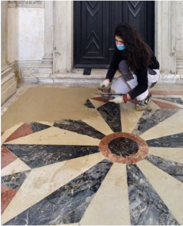
FIG. 4 Operazioni di desalinizzazione dei pianerottoli intermedi
