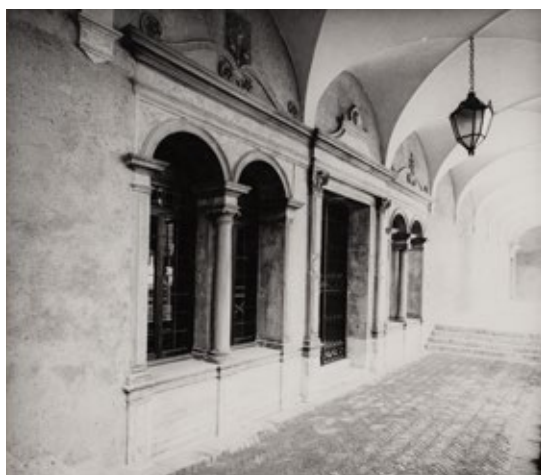
4. Il portale prima durante dopo i restauri degli anni '50 condotti da Ferdinando Forlati e promossi da Vittorio Cini, Venezia, Fondazione Giorgio Cini, Fototeca dell'Istituto di Storia dell'Arte
