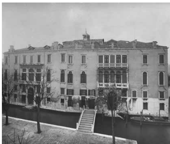
Veduta di Palazzo Cini dal Campo San Vio
